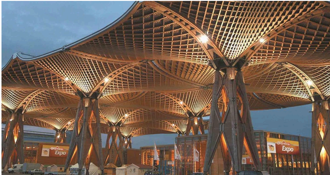
Toiture développée pour l'Exposition Universelle de Hanovre, en 2000. © Johannes Natterer
