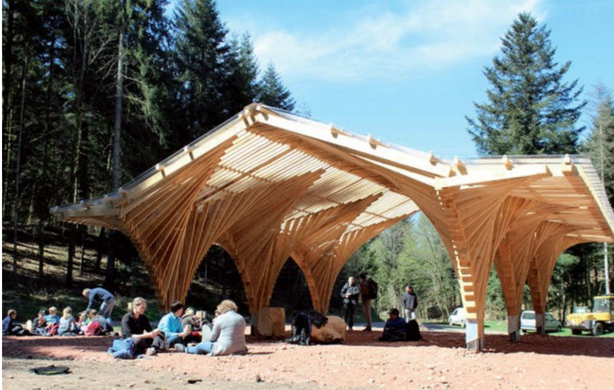
Abris en forêt, commune de Bertrichamps Auto-construction
